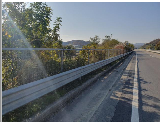
난간 및 연석 전경
